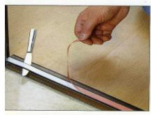
Jetzt legen Sie den am Türblatt zu befestigenden Magnetstreifen auf die Magnetleiste und ziehen die Schutzfolie ab.
