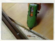
Ein Trick, um den Dübeln bei zu groß geratenen Bohrlöchern festen Halt zu geben; vor dem Einsetzen etwas Heißkleber einspritzen.
