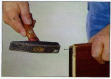
Zuletzt hängen Sie die Tür noch einmal aus und fixieren den Magnet-Türstreifen durch zusätzlich eingeschlogene kleine Nägel.
