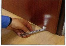
Bei geschlossener Tür können Sie den selbstklebenden Magnetstreifen mit dem vorher eingelegten Messer unten ans Türblatt drücken,
