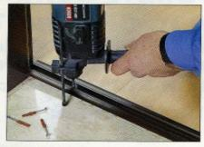
Nachdem man drei Befestigungspunkte vorgebohrt hat, benutzt man das Profil als Schablone für die Bohrungen im Boden.
