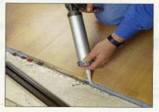
Bevor Sie das Alu-Profil auf die Türschwelle schrauben, sollten Sie die gesamte Montagefläche sorgfältig mit Silikon ausspritzen.
