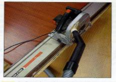
Die Tür wird ausgehängt und mit Hilfe der Handkreissäge und einer Führungsschiene entlang der Markierung abgeschnitten.
