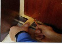
Mit Hilfe eines 6 mm dicken Brettchens läßt sich nun die Unterkante des Türblattes parallel zur montierten Bodenleiste anreißen.
