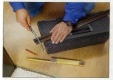
Die neue Dichtschiene wird ausgemessen und mit der Pucksäge abgelängt. Anschließend die Sägekanten mit der Feile glätten.
